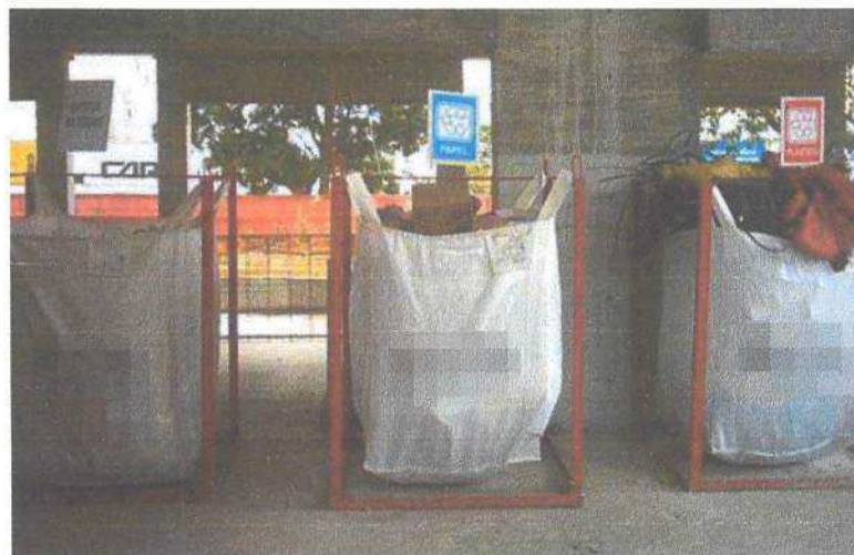
Figura 9 – Organização de resíduos em canteiro de obras
